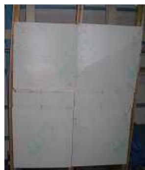
終了後状況写真
