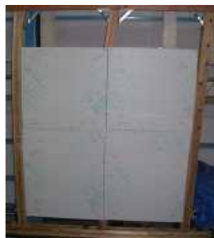
終了後状況写真
