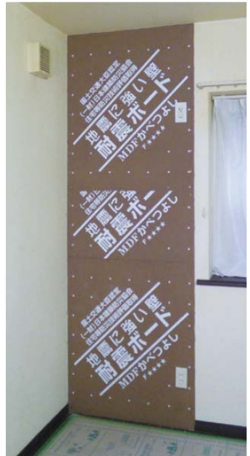
[施工イメージ]
