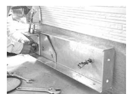
基礎補強用鋼材
