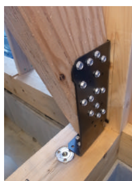
内壁：両真壁・片側大壁 ブラケット内付
