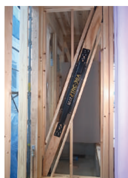
内壁：両真壁 ブラケット内付 間柱設置（例）
