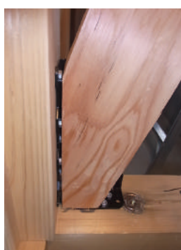
内壁：両真壁・片側大壁 ブラケット内付
