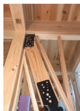
内壁：両真壁 ブラケット内付 間柱設置（例）
