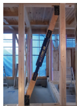
内壁：片側真壁・片側大壁 ブラケット外付
