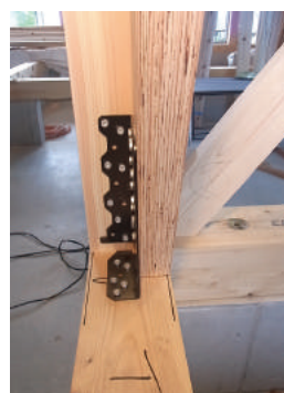
内壁：片側真壁・片側大壁 ブラケット外付
