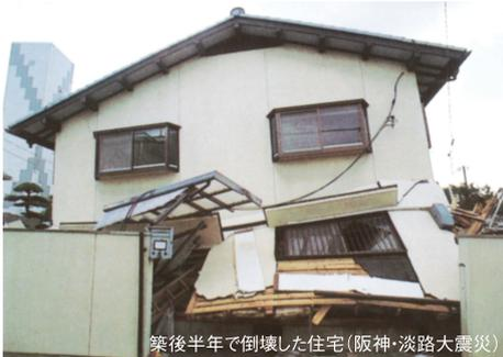
築後半年で倒壊した住宅(阪神・淡路大震災)
